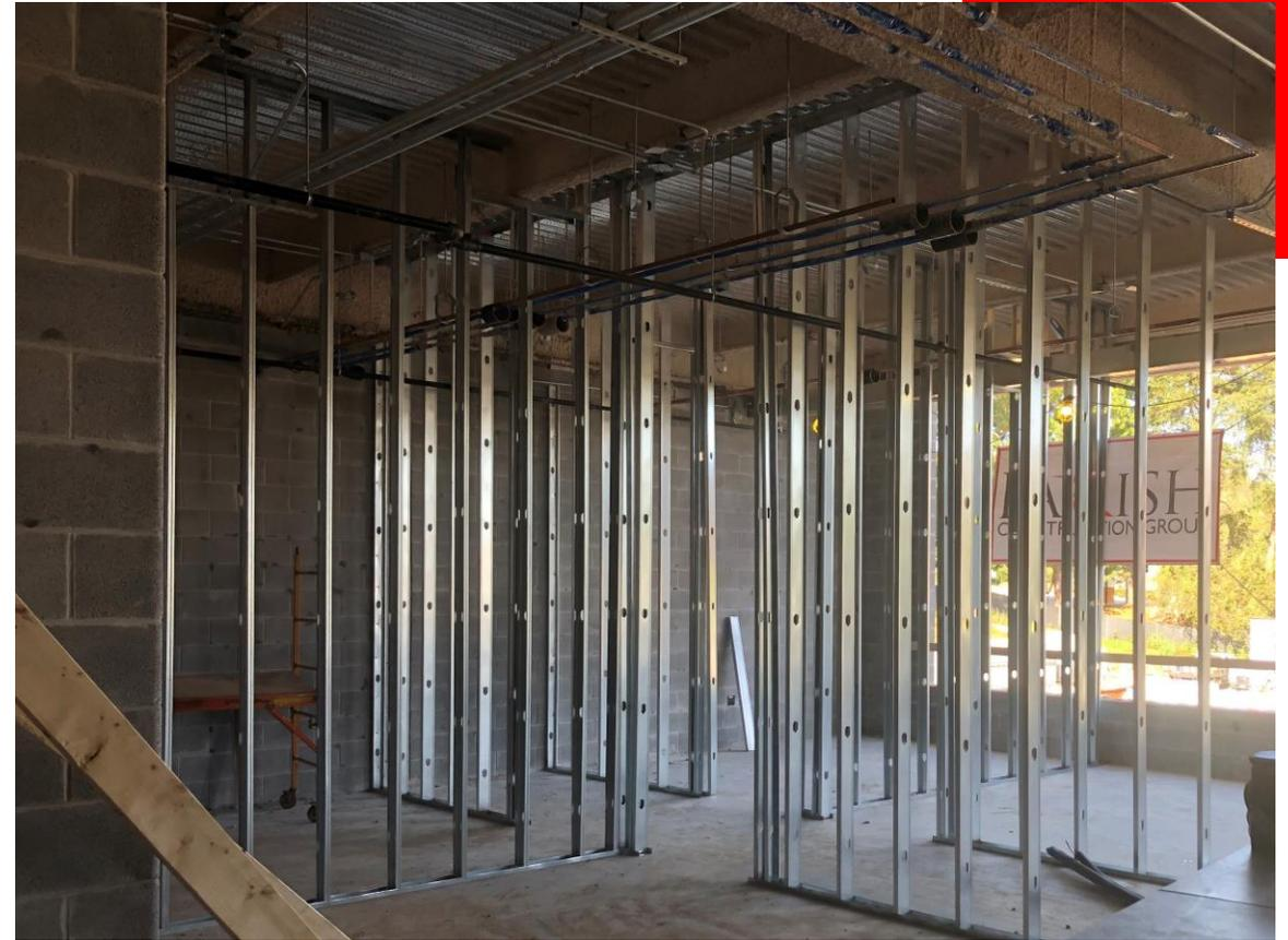
2<sup>nd</sup> Floor Interior Metal Stud Framing Progress
